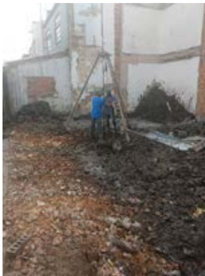
Fig.6. Proceso de pilotaje por métodos manuales debido a la restricción de espacio en la obra Fuente Juan Gabriel Bonilla.2020
