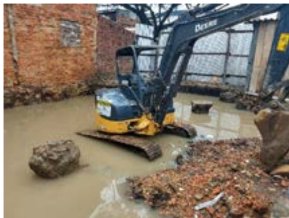
Fig. 5. Alto nivel freático sumado al régimen de lluvia por época invernal que provocó demoras en el proceso de cimentación. Fuente Juan Gabriel Bonilla.2020
