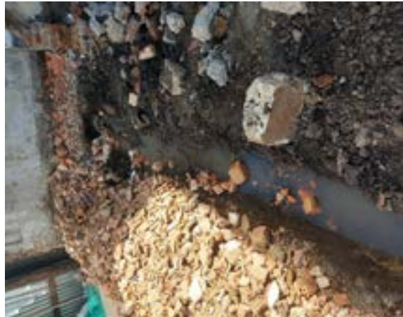
Fig.4. Evidencia de redes que quedan expuestas en el proceso de excavación. Fuente Juan Gabriel Bonilla.2020
