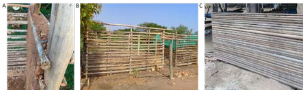
Figura 5. Fotografías tomadas en Pelaya – Cesar del sistema constructivo donde se aprecia: A. estructura de bahareque con caña. B. prototipo estructural de bahareque con raquis de palma. C. prototipos de acabados con raquis de palma.
